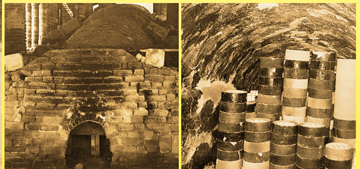
Dragón chino tradicional horno (龙窑 Long Yao). Boca de alimentación y procedimiento de llenado de porcelana eléctrica (colección privada)
